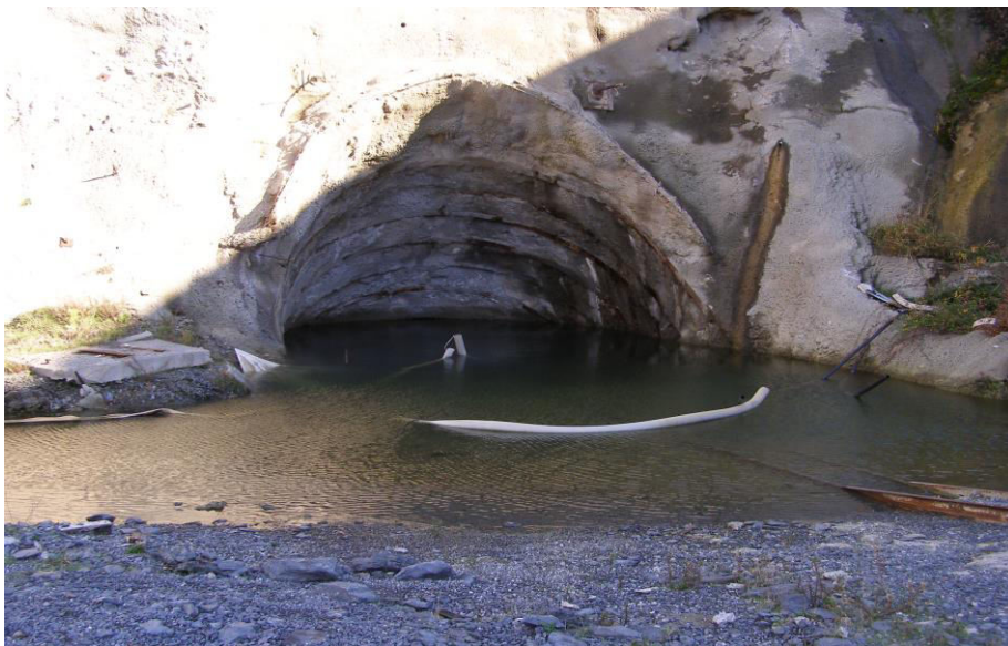
Εικόνα 6.23: Άποψη της εισόδου της σήραγγας υπερχείλισης του Φράγματος Μανικίων
