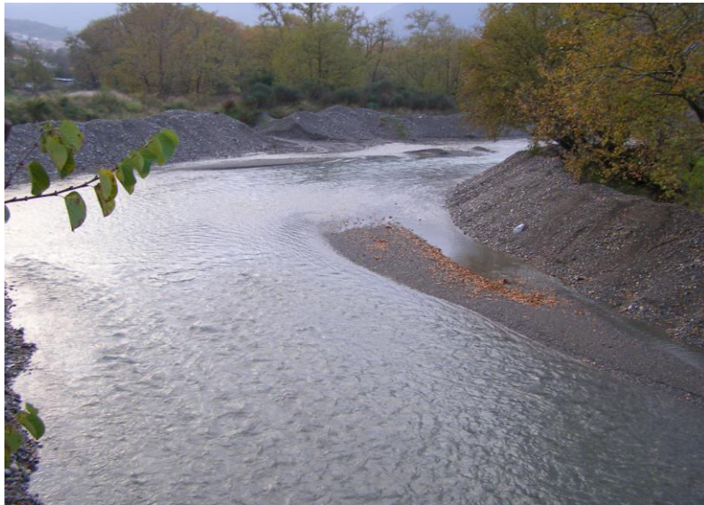
Εικόνα 6.22: Άποψη από τη Γέφυρα Μανικιάτη στο Μονόδρι της κοίτης του ποταμού στα ανάντη. Διακρίνονται έργα αντιπλημμυρικής προστασίας με απόθεση σωρών κροκαλών και αμμοχάλικων
