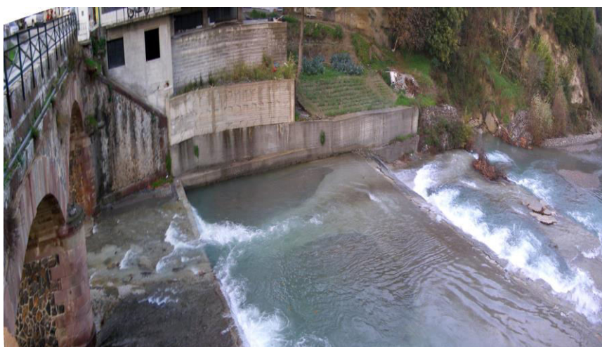
Εικόνα 6.20: Γέφυρα διέλευσης του ποταμού Μανικιάτη στο Μονόδρι
