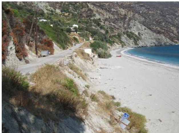
α β Φ.22 Προβλήματα αστάθειας στον παραλιακό δρόμο Κορασίδας λόγω θαλάσσιας διάβρωσης στον πόδα του πρανούς του δρόμου (σκόπευση προς Β)
